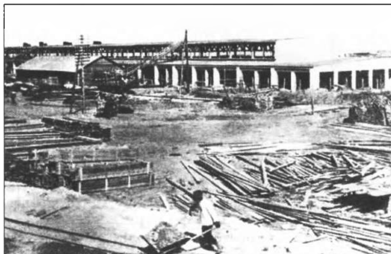
Рис. 3. На строительстве СТЗ
