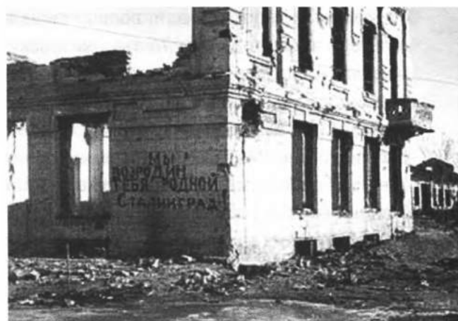
Рис. 25. Разрушенный дом с надписью «Мы возродим тебя, родной Сталинград!»
